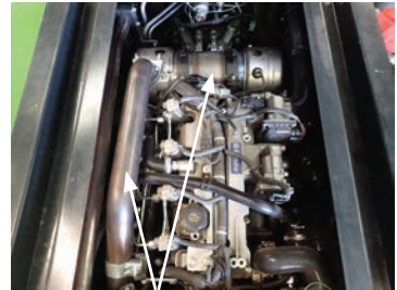
Eksosrørline og D.O.C. (dieseloksidationskatalysator)
