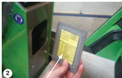
Oversikt over sikringer – baksiden av sikringsdekselet
